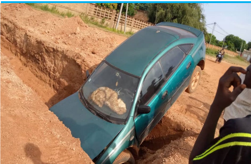
Un accident dans une rue à Tenkodogo en 2019 (causé par l'absence de ruban de signalisation)
