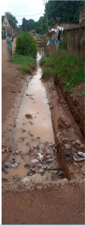
Images du caniveau qui occasionne des inondations en cas de pluie sur la RB13 à Banfora (Août 2021)
