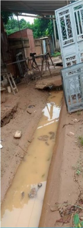
Images du caniveau qui occasionne des inondations en cas de pluie sur la RB13 à Banfora (Août 2021)
