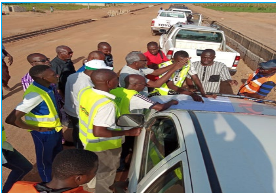
Visite des chantiers du 11 décembre à Tenkodogo (en 2019)
