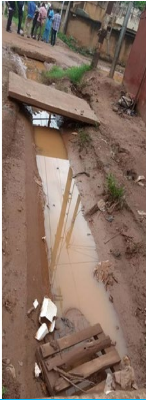
Images du caniveau qui occasionne des inondations en cas de pluie sur la RB13 à Banfora (Août 2021)
