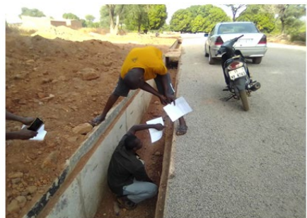
Exercices de vérification des dimensions des routes et des caniveaux par les points focaux de Sindou
